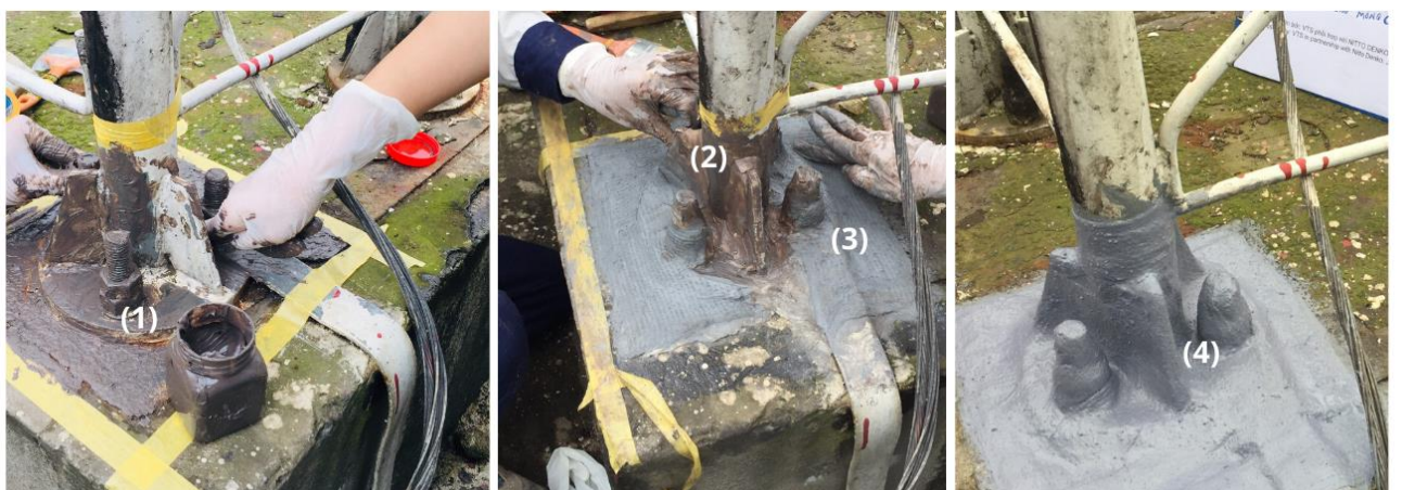
(1) Mỡ lót ức chế ăn mòn | (2) Sét trám khe tạo phẳng | (3) Băng cuốn bảo vệ | (4) Sơn phủ kháng UV
