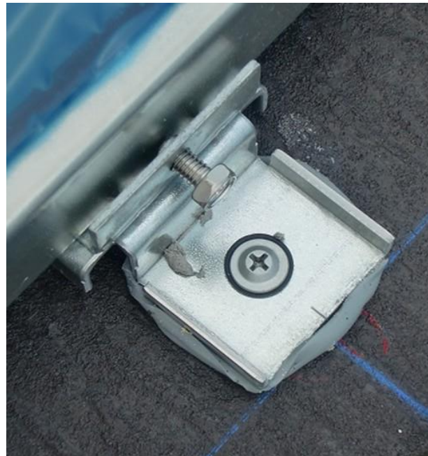
Trám keo silicone chống thấm nước sau khi lắp đặt
