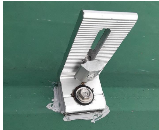
Trám keo silicone chống thấm nước sau khi lắp đặt
