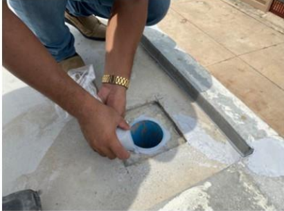
1. Vệ sinh bề mặt, đục V quanh cổ ống, lót và trám keo RF134
