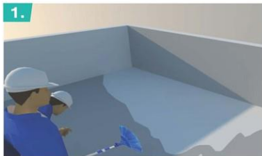
1. Vệ sinh bề mặt và sửa chữa vết nứt, nếu cần
