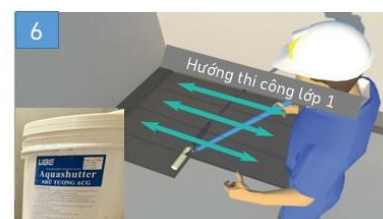
2. Dùng chổi, lô quét chống thấm Aquashutter lên toàn bộ bề mặt. Chờ khô 2 giờ
