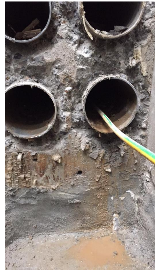
| Chống thấm . Waterproofing
