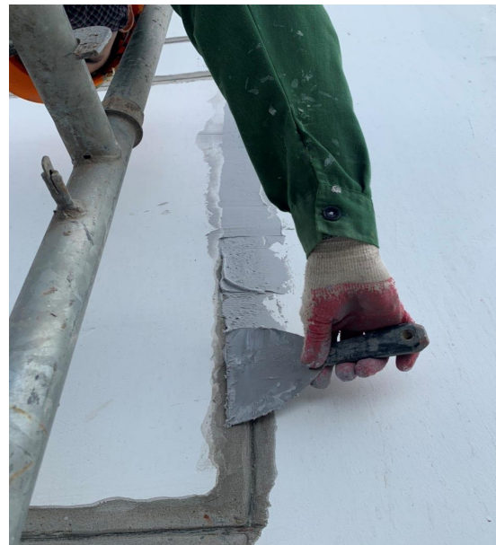
| Xử lý nứt . Crack Repair
